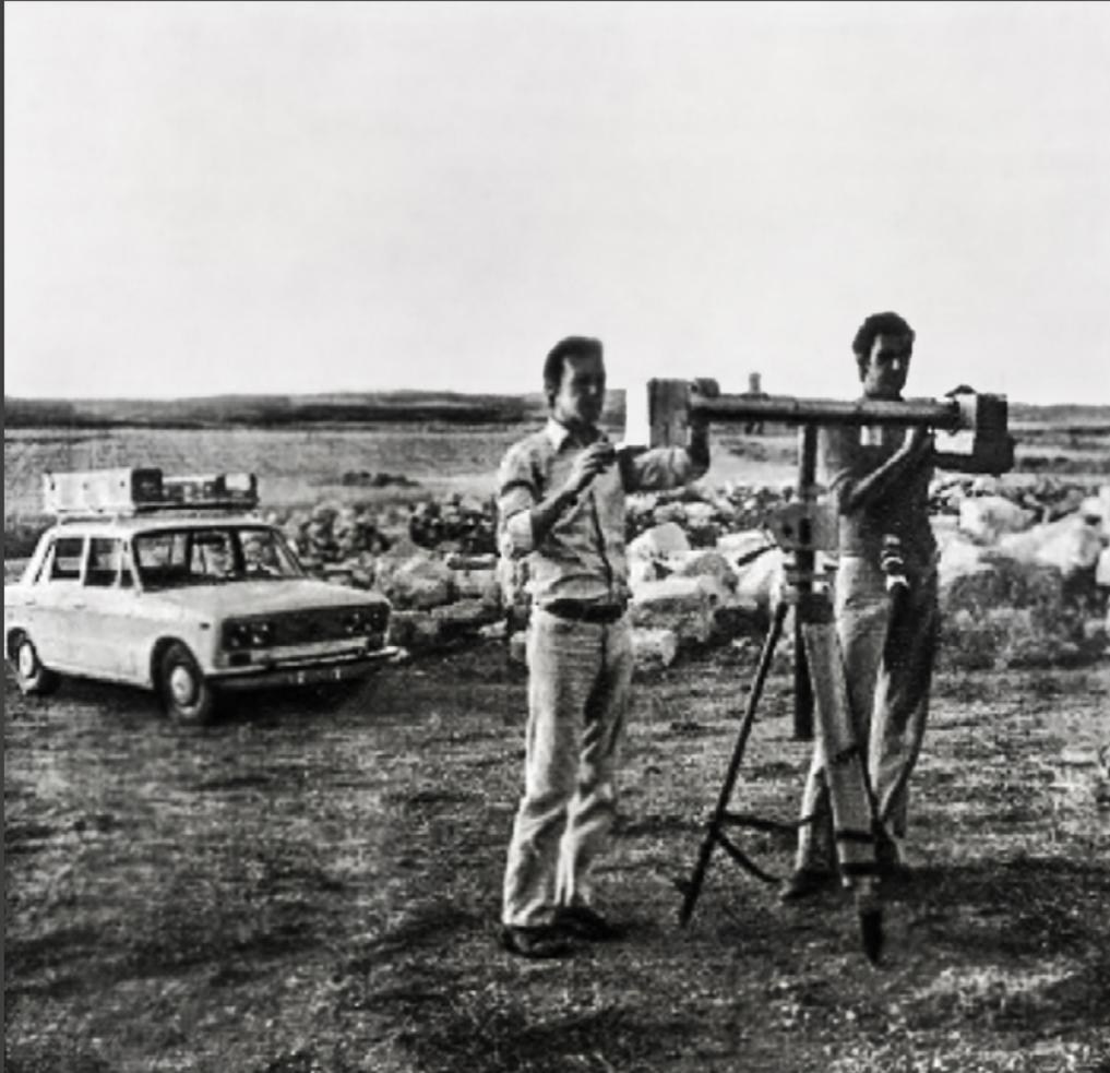
Figura 37.- El equipo de Antonio Almagro Gorbea preparando una bicámara para el levantamiento fotogramétrico del anfiteatro de Segóbriga en 1973. (Almagro, 1973, 45).
